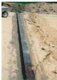
Usazení žlabových těles do betonového lože
