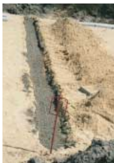
Uložení betonu
