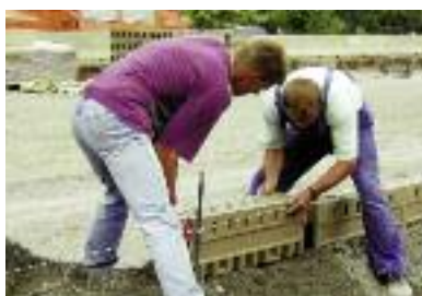
ACO DRAIN Monoblock – jednoduchá montáž bez zvedacího zařízení.
