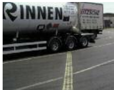
ACO DRAIN® Monoblock RD 200 V jako odvodnění parkovacích stání pro kamiony
